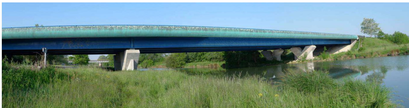
Figure 26 – Les infrastructures de transport génèrent de nombreuses collisions avec la faune. La loutre est particulièrement touchée dans l’Estuaire et basse vallée de la Charente car beaucoup de pont n’ont pas la perméabilité pour la faune qu’à cet ouvrage de l’A837. Cabariot, mai 2010, cliché PJ
