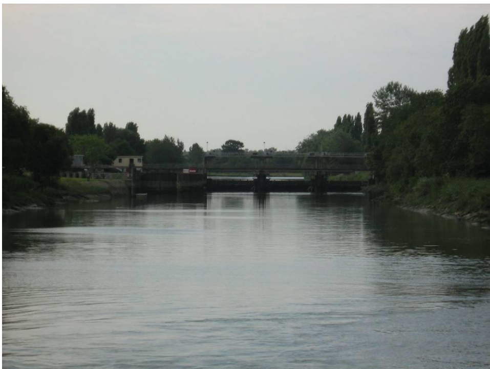
Barrage de St Savinien
