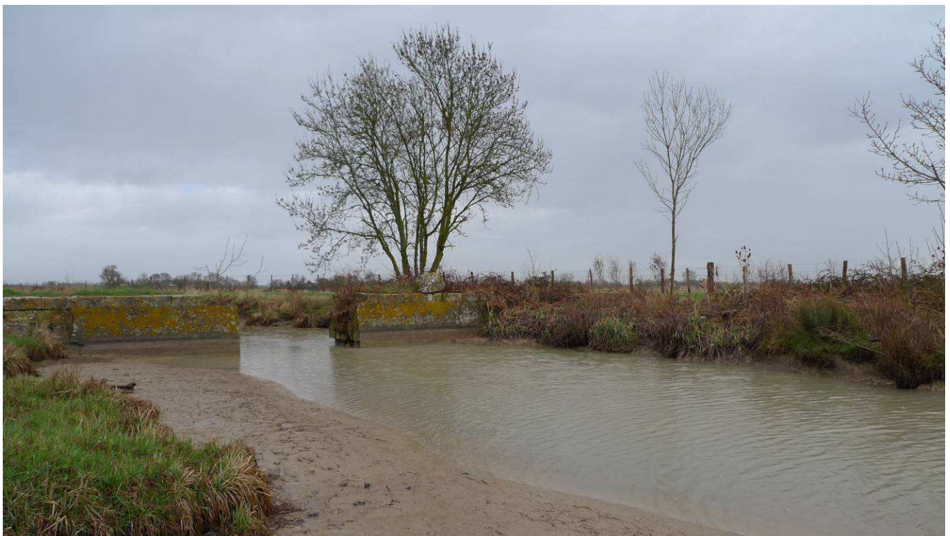
Figure 33 – Drainage des parcelles par un abaissement soudain des niveaux d'eau dans les canaux drainants, La Vallée, cliché Ph. Jourde.
